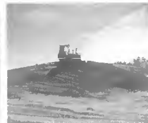
Humuszban gazdag fedőréteg kialakítása
